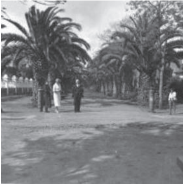
3. Cañones utilizados como bolardos al comienzo del segundo tramo del Camino Largo. (Foto Electromoderno 1930-1940. FEDAC.)
