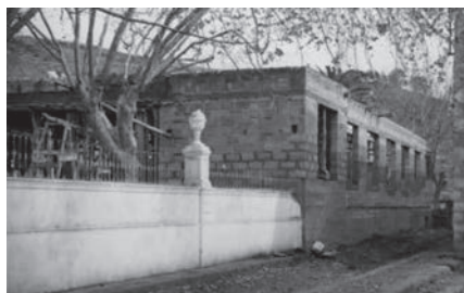
18. Vista lateral del edificio de Correos en construcción junto a la Iglesia de Santo Domingo. (Foto: Archivo Fotográfico del Museo Postal y Telegráfico, 1956-1957.)
