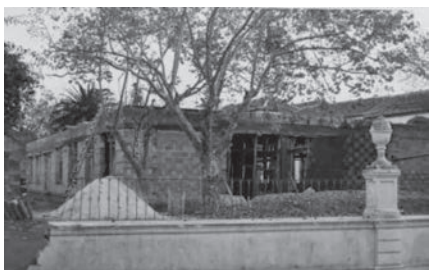
17. Vista de la fachada delantera del edificio de Correos en construcción y restos del antiguo muro y valla de la Plaza de Santo Domingo. (Foto: Archivo Fotográfico del Museo Postal y Telegráfico, 1956-1957.)
