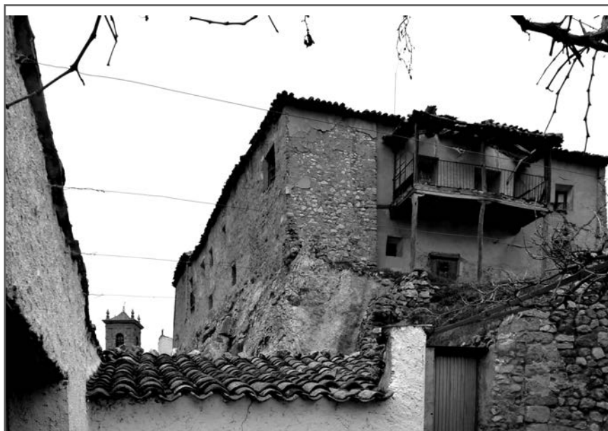
5. Casa Alta en Deza (Soria). Balcón mirador apoyado sobre pies derechos y zapatas.
