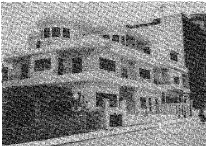
Foto 7. José Blasco, Edificio Ángel Núñez en construcción, 1933. Foto con tiraje de época (archivo Delgado Campos, Santa Cruz de Tenerife).
