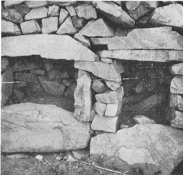
Fig. 44 - Torre de Lara. Nichos intermedios, 2 y 3, en la cámara provista de estas alacenas, de 1'5 m. ancho (III, 231). Fot. J. Serra, 1962
