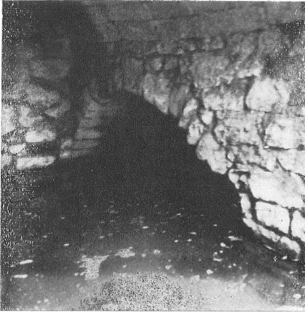
Fig. 21 - Lanzarote, Pozo 1.º de San Marcial. Detalle del arco lateral en el interior del aljibe. Foto J. Serra, 1962 (III, 203)
