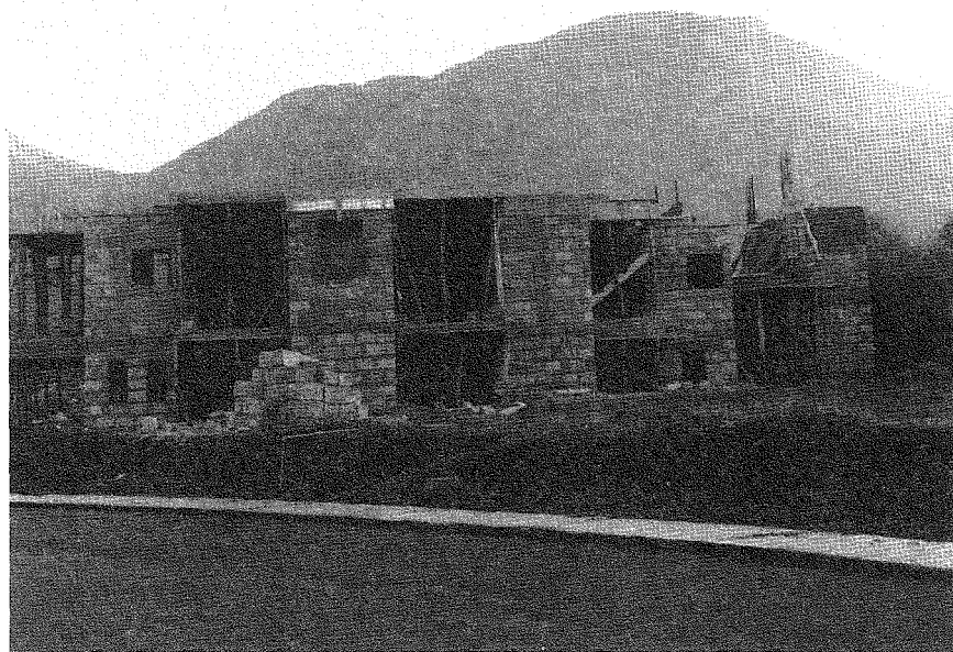
Figs. 8-9. E. Westerdahl, Edificio de apartamento en Bajamar en construcción , 1964 (foto de negativo original; Fondo Westerdahl, Gobierno de Canarias).
