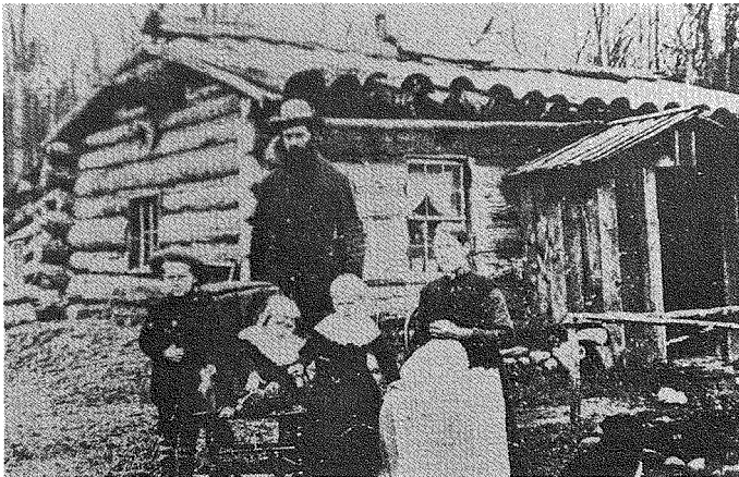
Cabaña de troncos de Nels Wickstrom, Wisconsin, 1893. La técnica constructiva empleada en su cubierta de canales de madera se advierte similar a la de la conservada en Tenerife, incluso en la pendiente de las canales y cobijas y en la protección utilizada en el caballete. (Foto anónima, c. 1893.)
