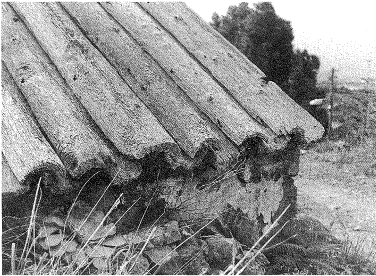
Detalle de la disposición de las canales y cobijas en la casa del Miradero Alto, Ycod de los Vinos. El diámetro de los troncos de madera de tea con los que se fabricaron no rebasaba los 35 cm., advirtiéndose más acabado el rebaje interior por donde desagua la cubierta. (Foto J. Gómez, 1998.)
