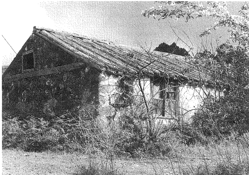
Casa con cubierta de canales de madera de tea del Miradero Alto, Ycod de los Vinos. En el mojinete, sobre el ventanillo lateral, asoma el extremo de la cumbrera en la que apoyan, formando ángulo, las canales y las cobijas. Un largo canalón invertido, a modo de caballete, protege la unión de los faldones. (Foto J. Gómez, 1998.)
